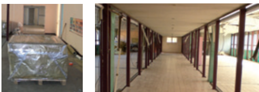
Démolition de l'école
